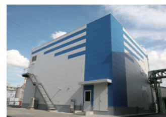
大阪ソーダ尼崎工場シリカゲル製造設備
