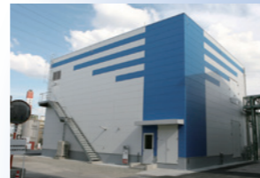
修飾型シリカゲル製造設備
