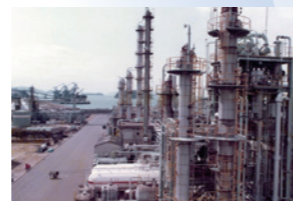
エピクロルヒドリン (EP) 製造設備
