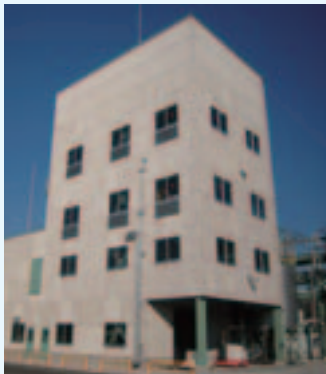
水島工場 エピクロルヒドリンゴム製造設備
