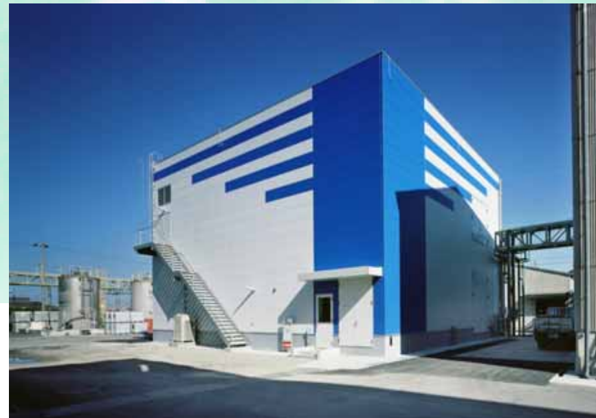
修飾型シリカゲル製造プラント新設 (2008年 / 尼崎工場)
