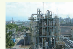
エピクロルヒドリンプラント
