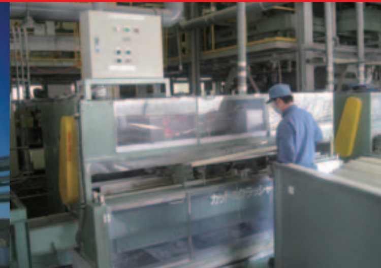
蛍光管リサイクルプラント
