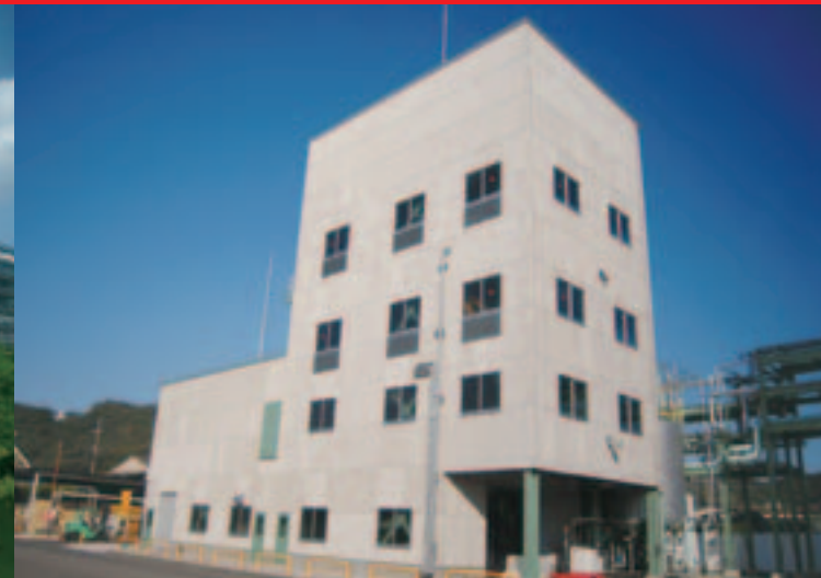
エピクロルヒドリンゴム製造設備建屋
