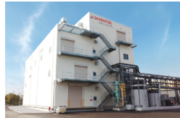
松山シリカゲル製造設備(2024年9月完成)
