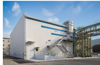
尼崎シリカゲル製造設備(2025年9月完成)
