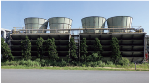
冷却水のリサイクル設備(冷水塔)
