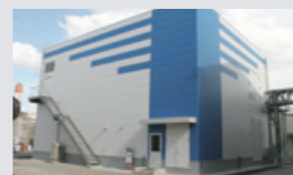
シリカゲル製造設備
