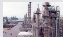
エピクロヒドリン(EP)製造設備
